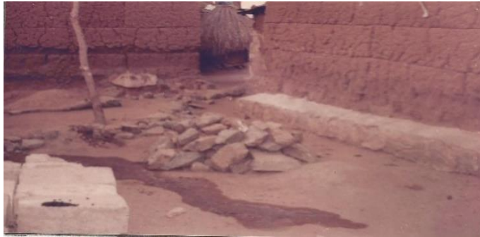
Photo 2 : Murette en migmatite et en ciment ceinturant une habitation Prise de vue : MAKPONSE, juin 2018
