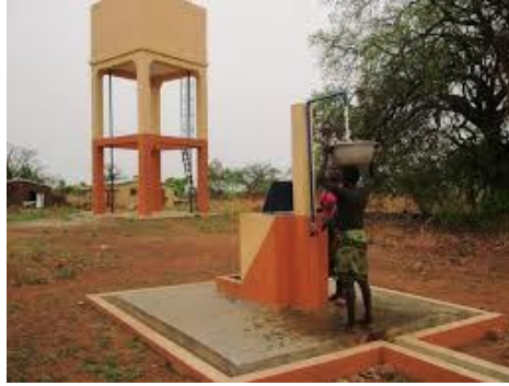
Photo3, Une Borne Fontaine Source : données de terrain
