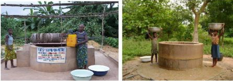
Photo 4&5: Puits à Grand diamètre réalisé respectivement par l'ONG GRASID à Solévohoué et par les communautés de Mintchihoué. Source : données de terrain
