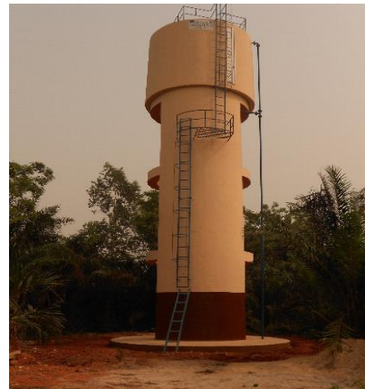
Photo 2 : un château d'eau à Doko (commune de Toviklin) Source : données de terrain
